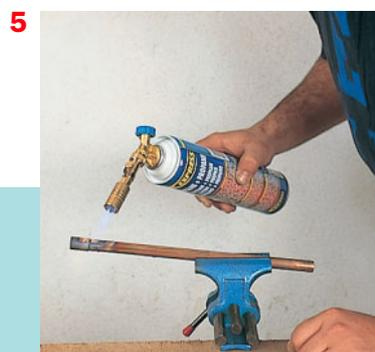
**5. Chauffer la zone à souder avec une lampe à souder ou un chalumeau à gaz.**
