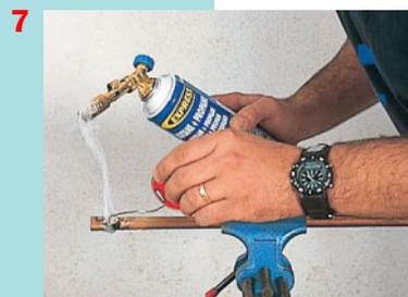
**7. Lorsque le cuivre est rougi, écarter la flamme et poser sur le raccord de la soudure à l'étain en fil. Au contact du cuivre chaud, ce métal d'apport fond et "file" par capillarité entre les deux éléments en comblant tout l'interstice.**
