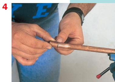
**4. Emboîter les deux pièces en tournant pour répartir la pâte décapante.**
