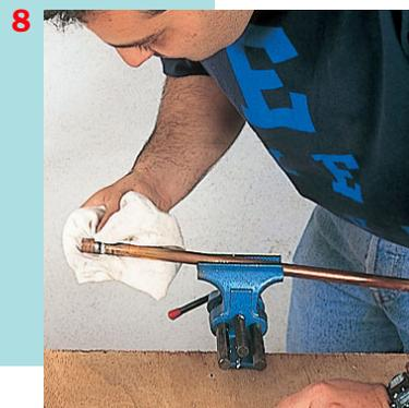
**8. Essuyer le tour du raccord avec un chiffon sec et propre, en faisant attention de ne pas se brûler.**
